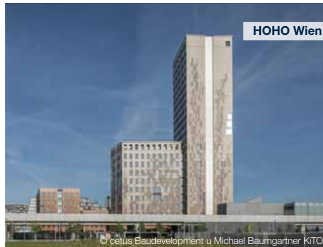
Wenn 800 Säulen aus Fichte 24 Stockwerke tragen. When 800 spruce columns support 24 floors.
