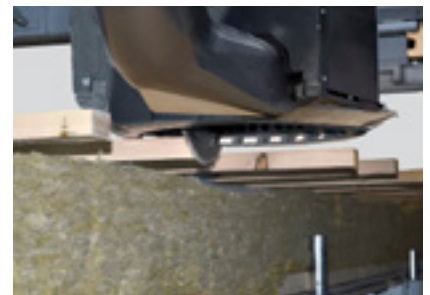
Formatieren der Dachlattung
